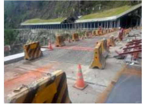
型鋼及花紋鋼板安裝銲接
