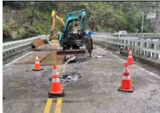
小型機具清除破碎混凝土
