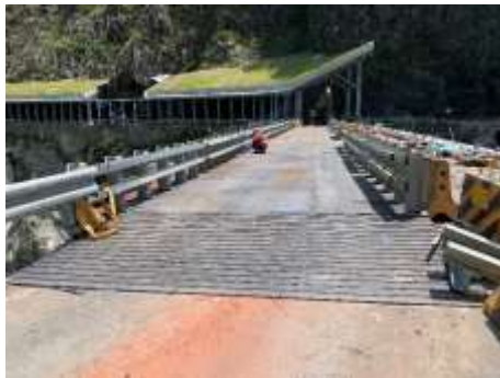
原有護欄移設安裝銲接
