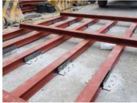
型鋼鋪設加固銲接
