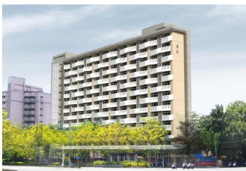
女生宿舍誠軒大樓新建工程
