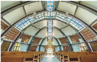
教堂內部結構以特殊防震系統三鉸拱(THREE - HINGED ARCH)建造在類似三角型頂端及兩端柱腳都有一鉸鍊接頭可吸收地震的能量。建築師以結構外露表示對架構系統忠實的表現，並以灰色防火漆突顯它的存在。
